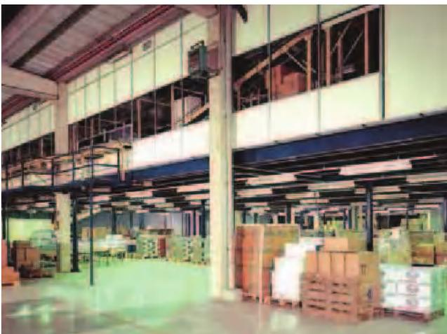
Eine gängige Anwendung ist die Nutzung des unteren Bereichs als Arbeitsbereich oder zur Abfertigung von Aufträgen, während im oberen Bereich getrennte Büro- oder Arbeitsräume eingerichtet werden. Diese werden mit Aluminiumtrennwänden und abgehängten Decken abgeteilt, um angenehme Arbeitsräume zu schaffen.
