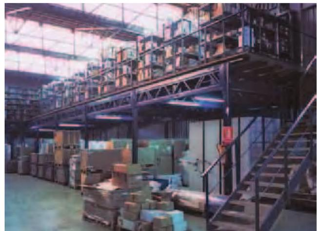
Auf der unteren Ebene der Bühnenkonstruktion werden großvolumige Produkte gelagert, oben wurden Regale zur Lagerung kleiner und mittlerer Waren aufgestellt.
