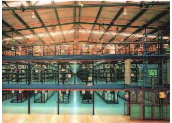
Die Bühne ist mit einem Kommissionierlager über Laufbrücken verbunden, die als Eingangs- und Abwicklungsbereich der Aufträge dienen, und mit einer Hebeplattform zum Auf- und Abfahren der Waren zwischen den verschiedenen Etagen ausgestattet sind.
